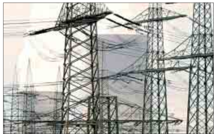
Kohlekraftwerk und Stromleitungen: Nach dem Willen der EU sollen Produktion und Stromnetz künftig getrennten Firmen gehören. Foto: dpa
